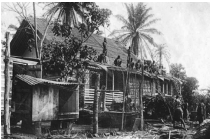
De barakken te Lambaréné zijn in aanbouw.
